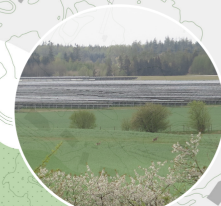
NORDENS STØRSTE SOLCELLEANLÆG
